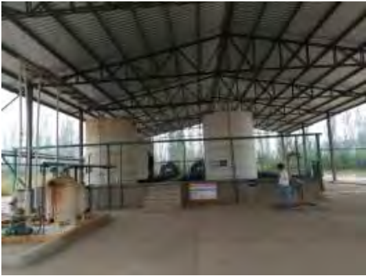
罐区整体围堰
