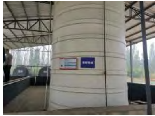
液碱储罐围堰
