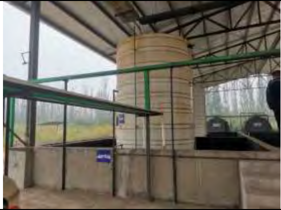
盐酸储罐围堰
